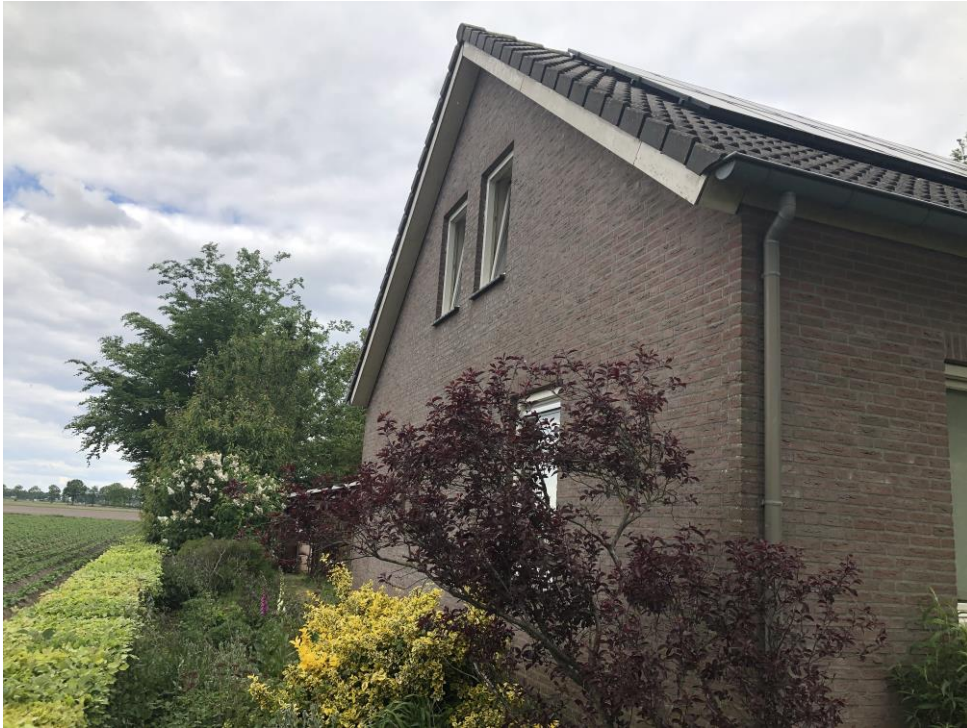
Figuur 2: Zijgevel woonhuis, mogelijke locatie voor vleermuiskasten
