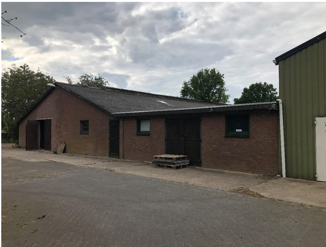
Figuur 4: Te slopen middelste (lage) deel van bebouwing
