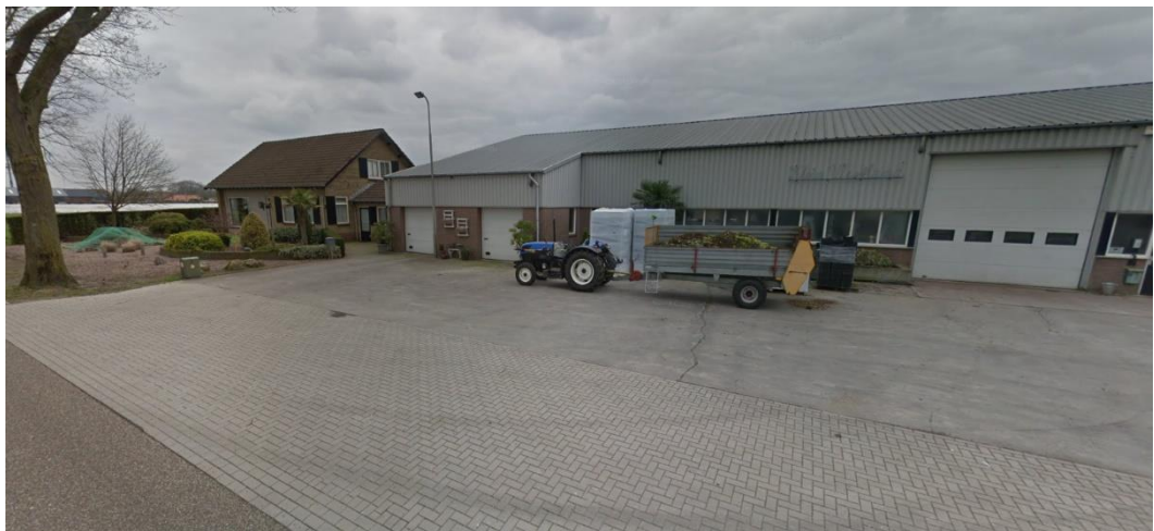
Bestaande bedrijfsgebouwen en -woning
