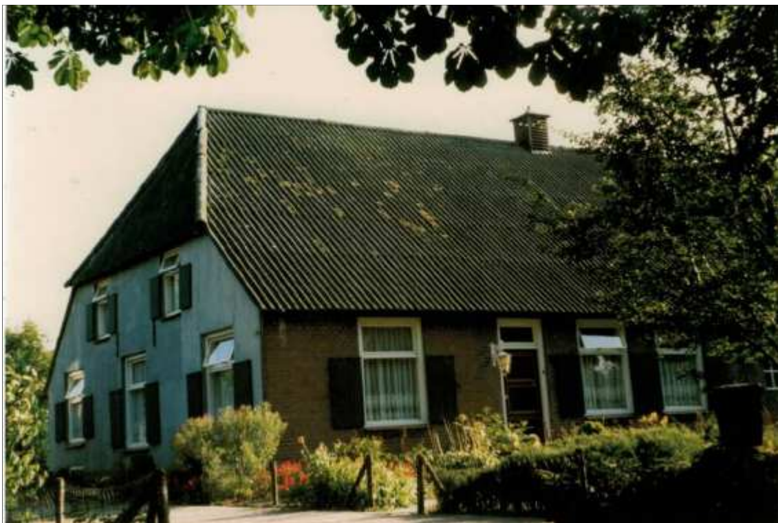
Aanzicht woongedeelte boerderij Esp 9 te Bakel vanaf wegzijde (Esp)- golfplaten dak
