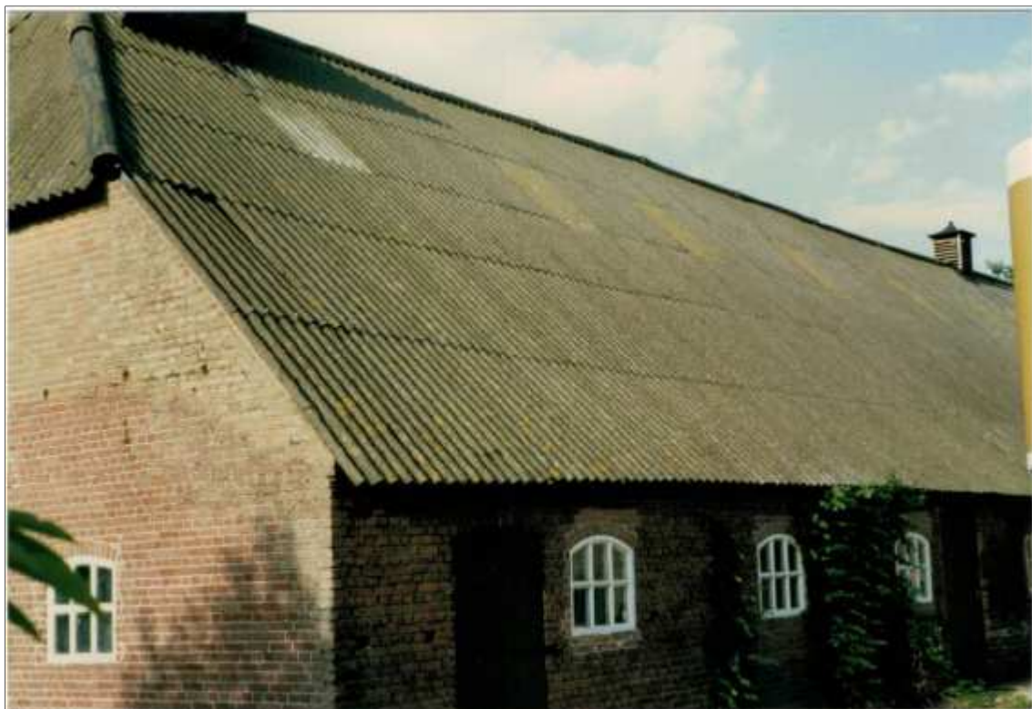
Aanzicht stalgedeelte boerderij Esp 9 te Bakel vanaf achterzijde woning
