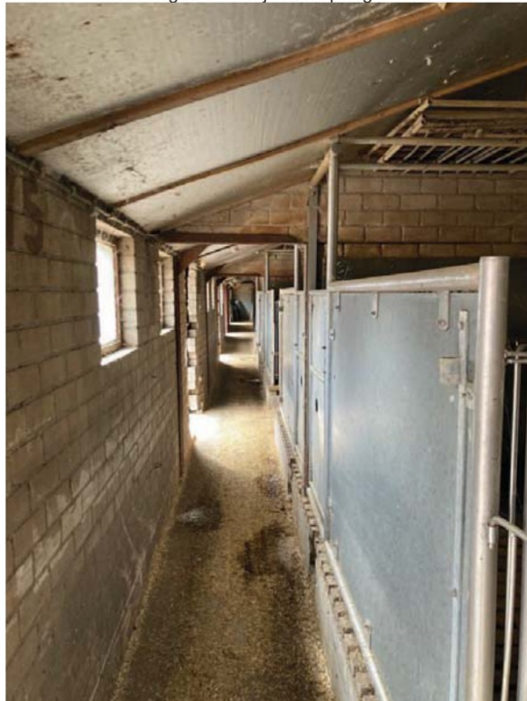
• Afbeelding 5: binnenzijde te slopen gebouw met dakisolatie
