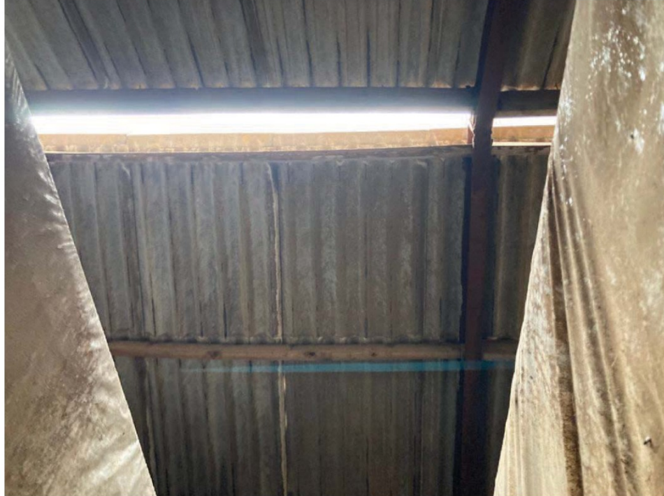
• Afbeelding 10: te slopen bebouwing natuurlijke ventilatie
