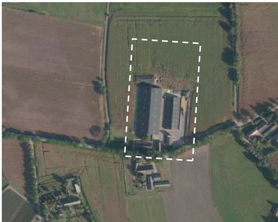
• Afbeelding 1 Luchtfoto projectlocatie
