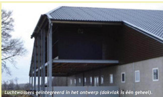
Goede standaard van de dak-gevelverhouding: 2:1 (een beeldbepalend dakvlak en een lage goothoogte).
