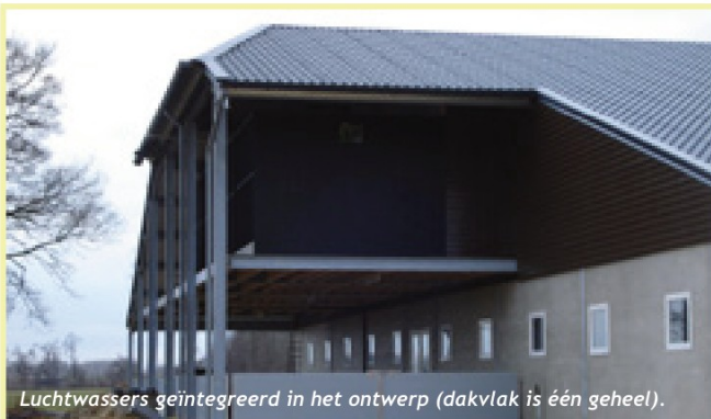
Goede standaard van de dak-gevelverhouding: 2:1 (een beeldbepalend dakvlak en een lage goothoogte).
