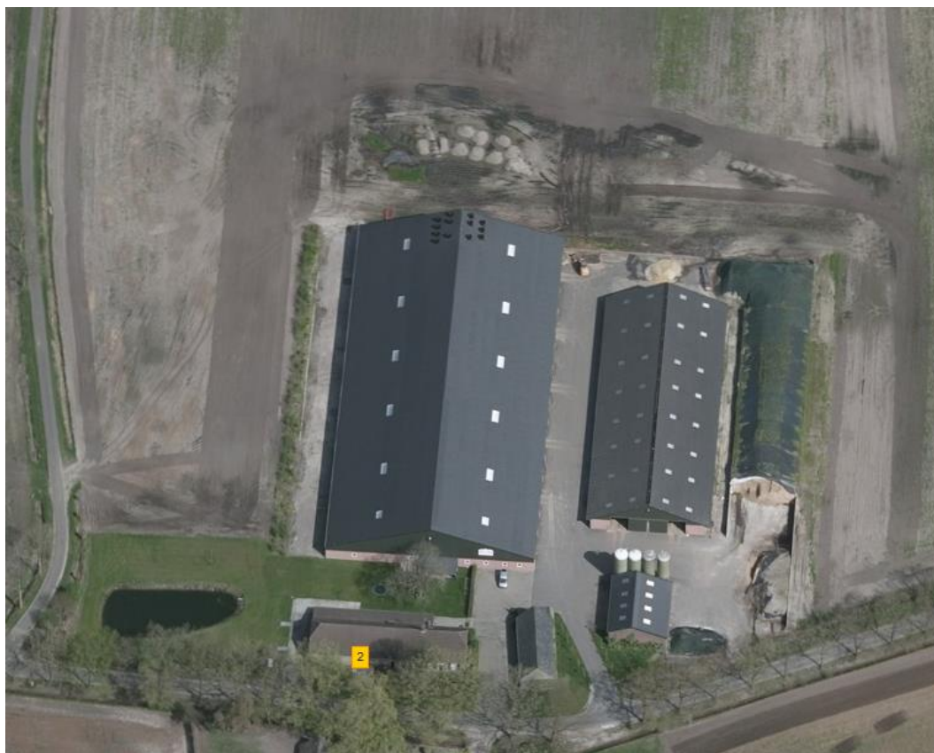
Figuur 2.1: Uitsnede luchtfoto ter plaatse van Esp 2 (bron: Cyclomedia)
