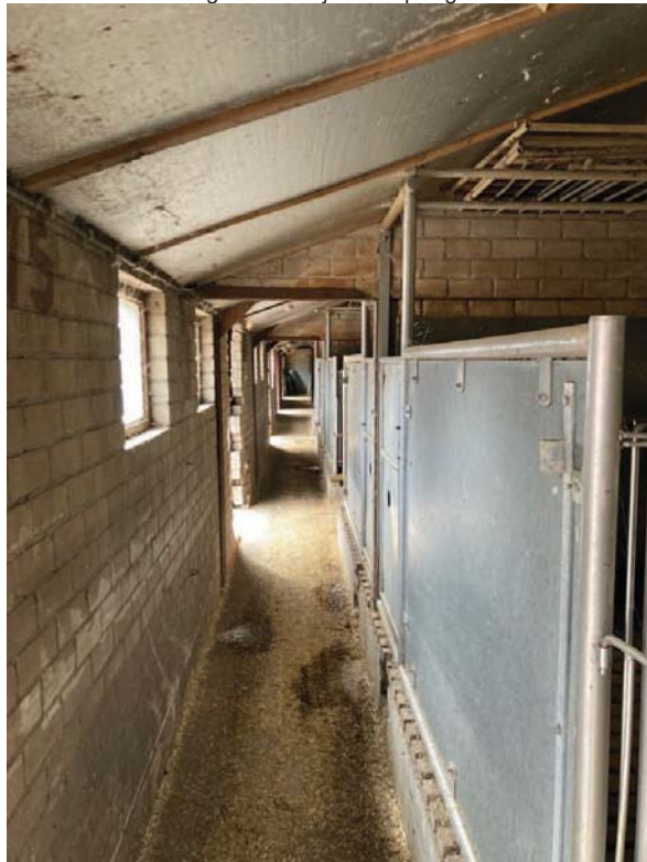
• Afbeelding 5: binnenzijde te slopen gebouw met dakisolatie
