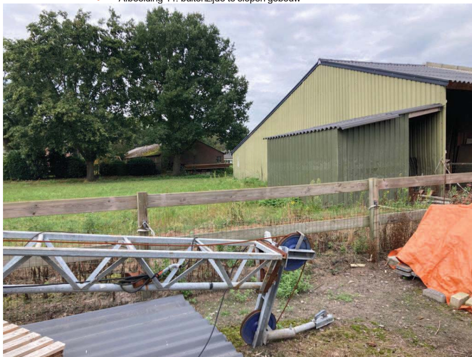
• Afbeelding 11: buitenzijde te slopen gebouw
