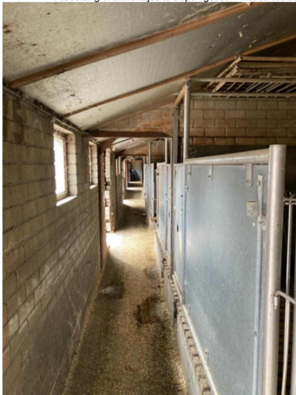
• Afbeelding 5: binnenzijde te slopen gebouw met dakisolatie
