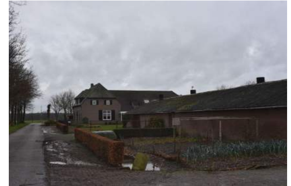
Door sloop van de bestaande stallen ontstaat er een optimale landschappelijke inpassing van het bedrijf.
