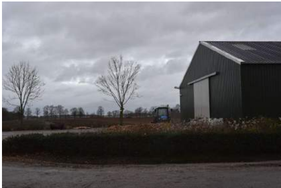
Achterzijde van loodsen.
