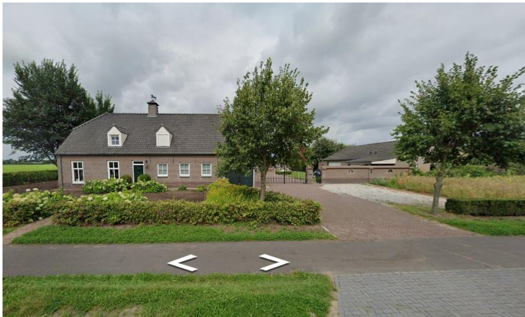
Figuur 3: Plangebied gezien vanaf de Dr. de Quayweg
