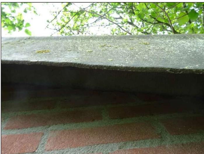
Onderkant dakrand (westzijde te slopen stalgedeelte)
