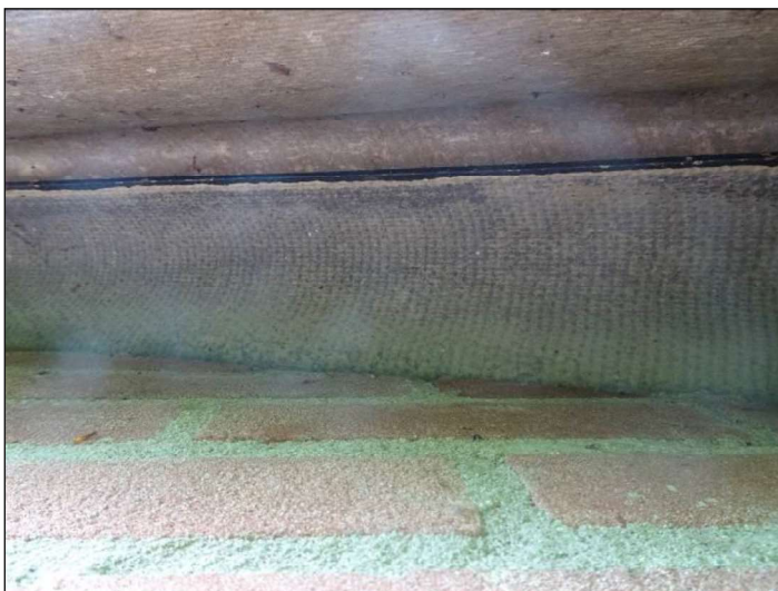
Onderkant dakrand (westzijde te slopen stalgedeelte)
