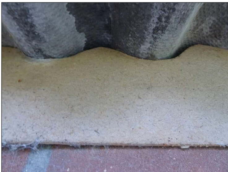
Onderkant dakrand (zuidzijde te slopen stalgedeelte)
