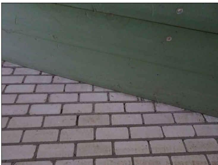
Binnenzijde westelijk muur te slopen stalgedeelte
