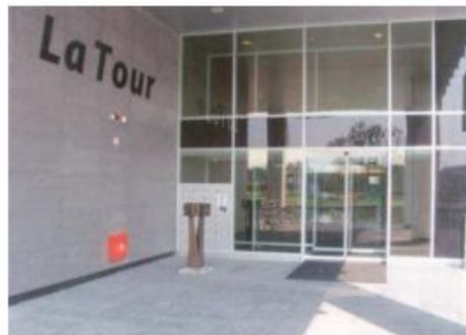
duidelijk herkenbare entree
