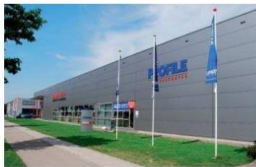
bedrijfsnaam op de gevel, bord en vlaggenmasten
