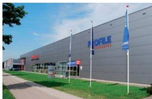
bedrijfsnaam op de gevel, bord en vlaggenmasten
