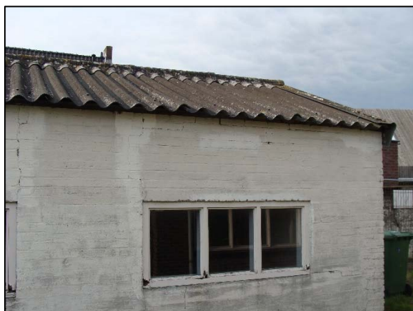
Foto 1. Te slopen schuur
