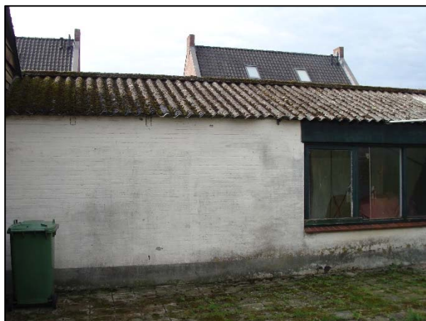
Foto 3. Te slopen schuur
