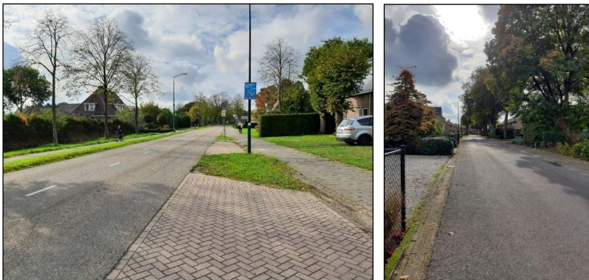
Afb. 2.10 Links: de Milheesestraat ten noorden van het plangebied. Rechts: de Antoniusstraat ten westen van het plangebied.
