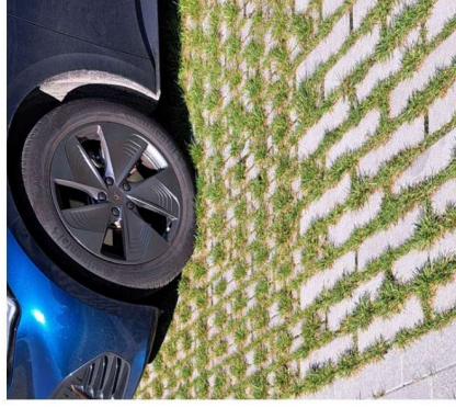
Parkeren op halfverharding
