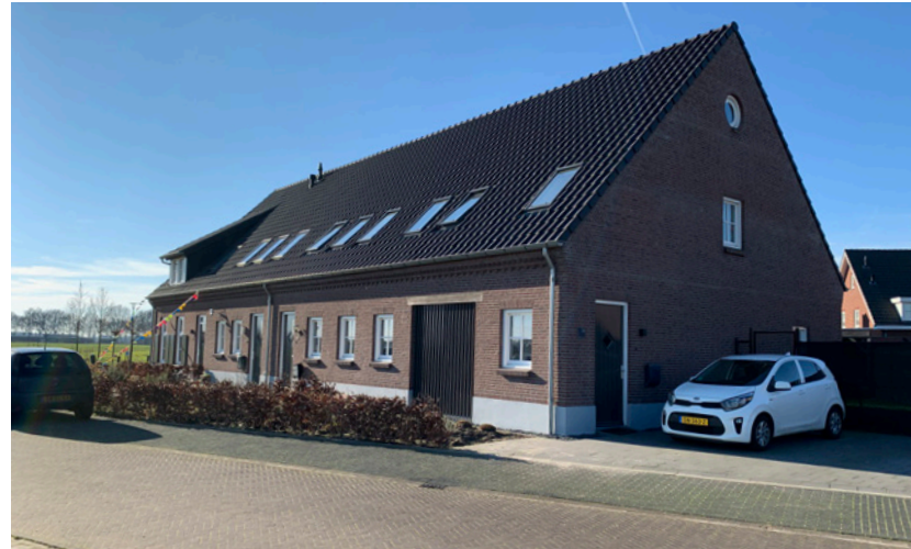
Drie wooneenheden aan de Millekens refereren naar langgevelboerderij: dominante lange kappen, ondergeschikte gevels, ingetogen kleuren en zorgvuldige detaillering met een gevelplint in pleisterwerk.
