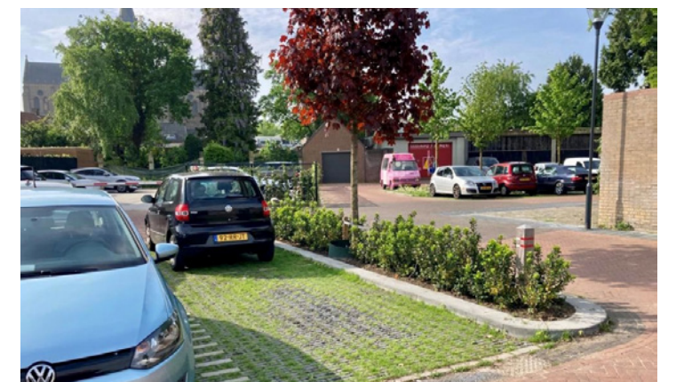
Groene inrichting van de buitenruimte met bomen en parkeervakken in grasbeton
