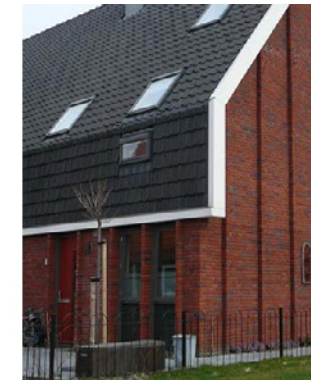
Voorbeelden van dakbedekking die doorgetrokken is over de gevel op de eerste verdieping. Verfijnde detaillering van de gevel.
