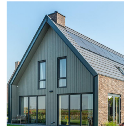
Een eenvoudige hoofdmassa, ingetogen materiaalgebruik en zonnepanelen zijn meeontworpen met het dakvlak
