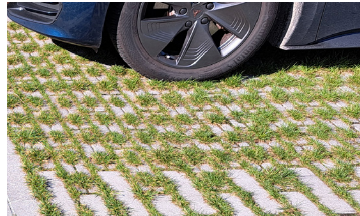
Parkeervakken in grasbeton
