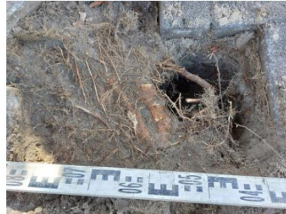
Afbeelding 6: intensieve beworteling onder de verharding
