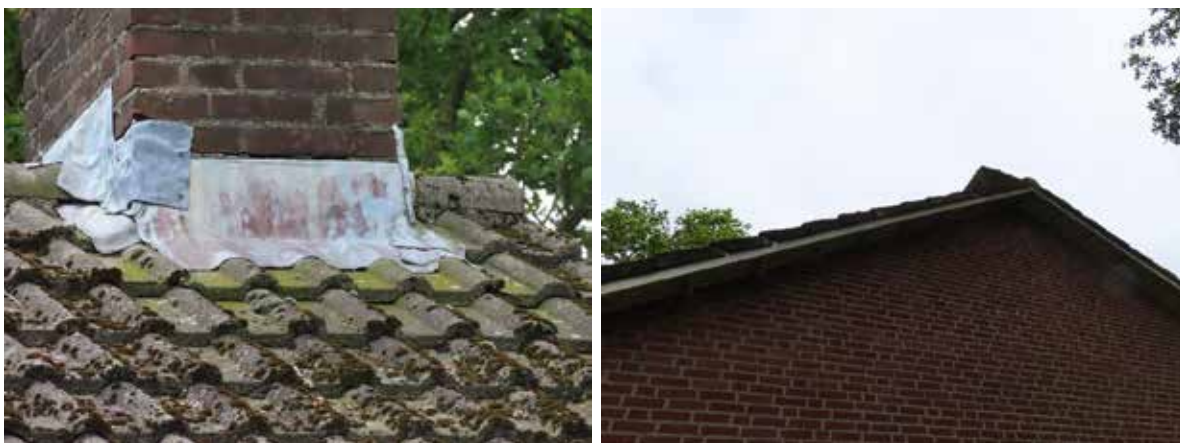
Afbeelding 19 t/m 22: Geen mogelijke rust- of verblijfplaatsen van vleermuizen aangetroffen in de te renoveren woningen en slopen bebouwingen. Bron: BNL advies.
