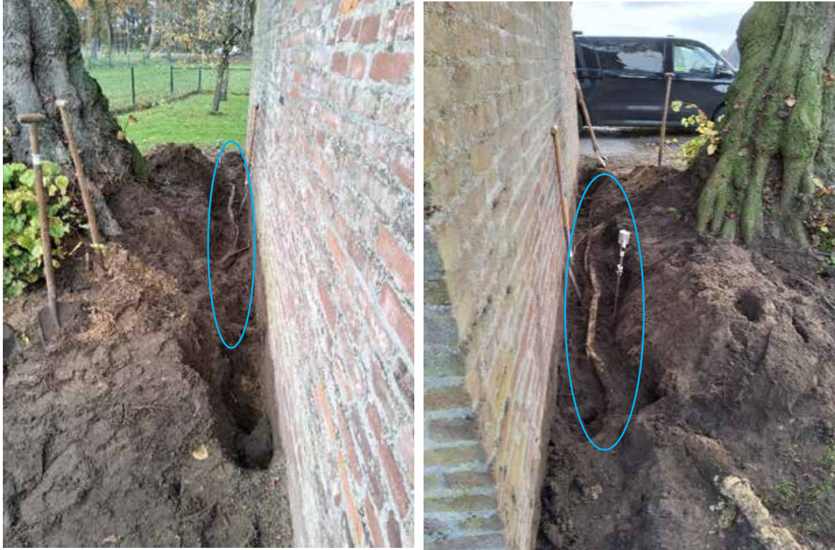
Afbeelding 10a+b, Beworteling in de profielsleuf toont duidelijk afbuigende groei van de boomwortels voor de fundering van de boerderij langs.
