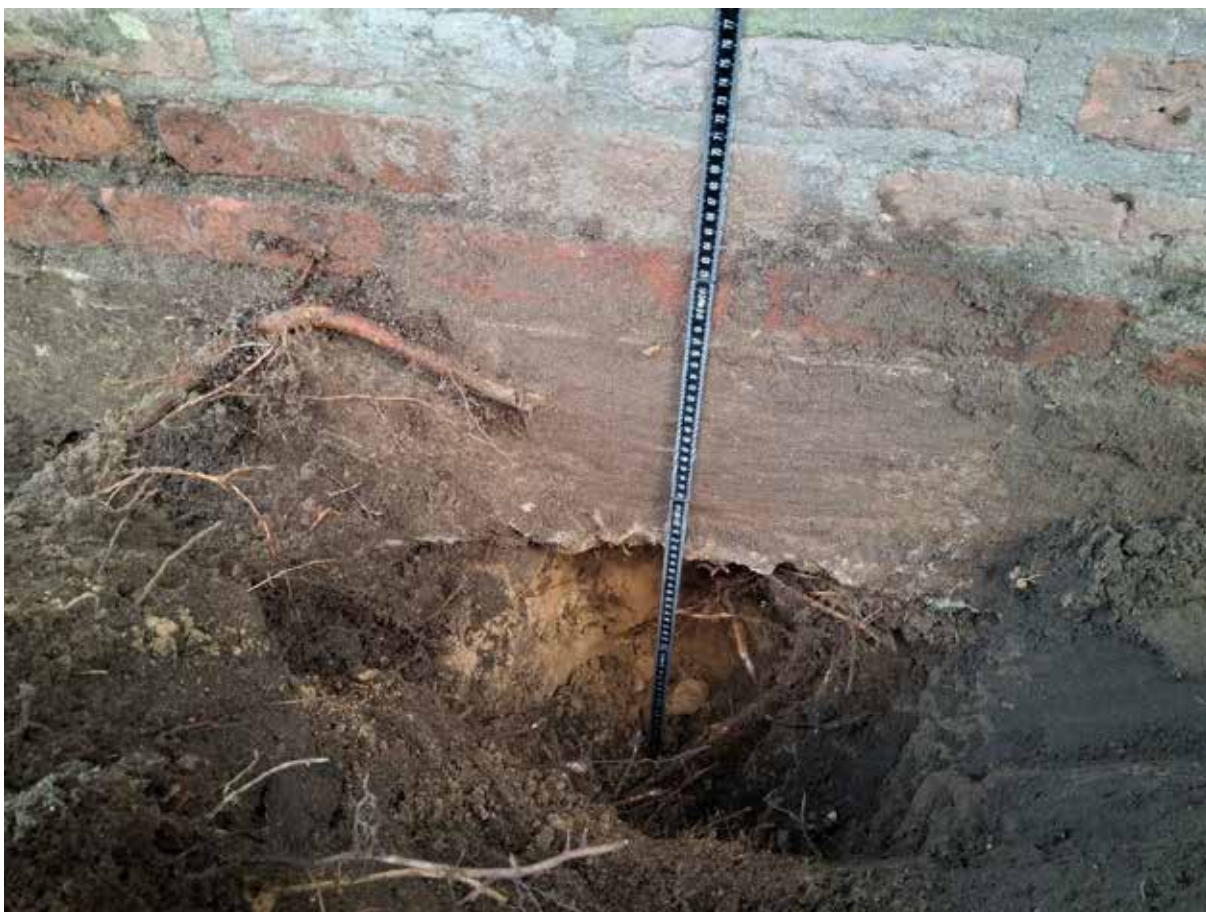
Afbeelding 9, Bodemopbouw en beworteling in de profielsleuf, waarbij bestaande fundering bloot is gelegd.
