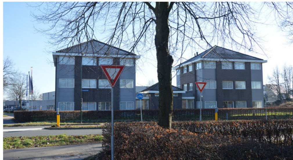
Kantoorbebouwing aan de Handelseweg
