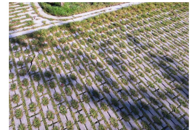
Calamiteitenroute in grasklinker
