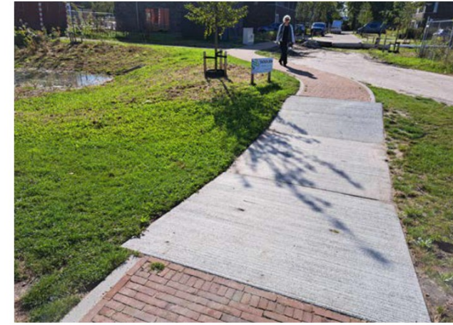
Betonpad door de wadi
