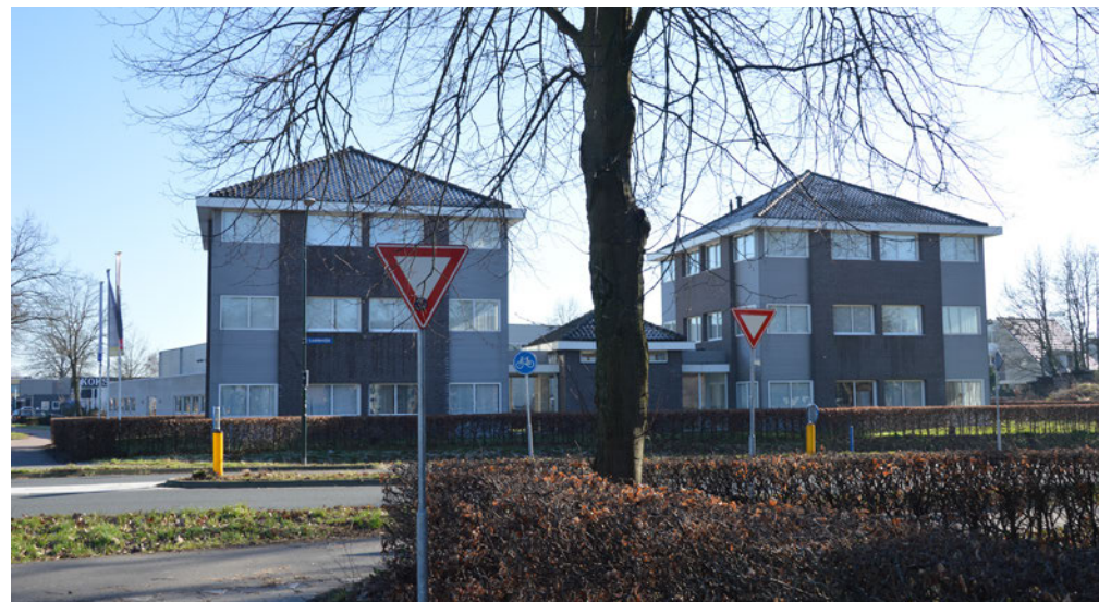
Kantoorbebouwing aan de Handelseweg
