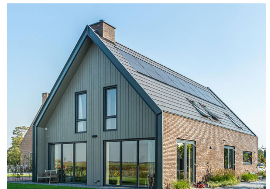
Een eenvoudige hoofdmassa, ingetogen materiaalgebruik en meeontworpen zonnepanelen
