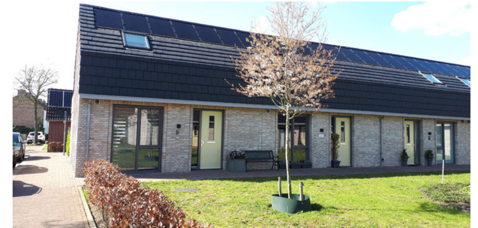
Woningen met een eenvoudige hoofdmassa en langgevel aan een collectieve tuin
