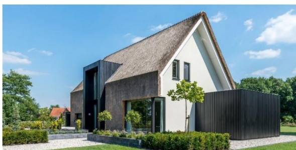
Afbeelding 18 (bron: Het Fundament Architectuur)
