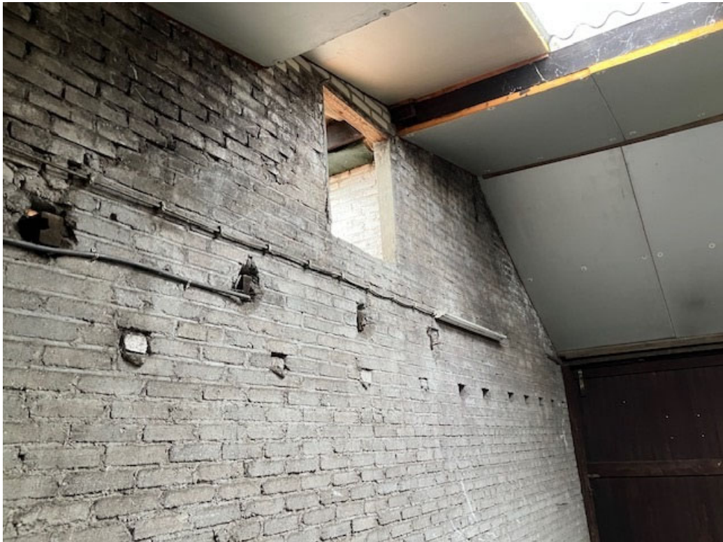
• Afbeelding 15: Binnenzijde ander te slopen bijgebouw
