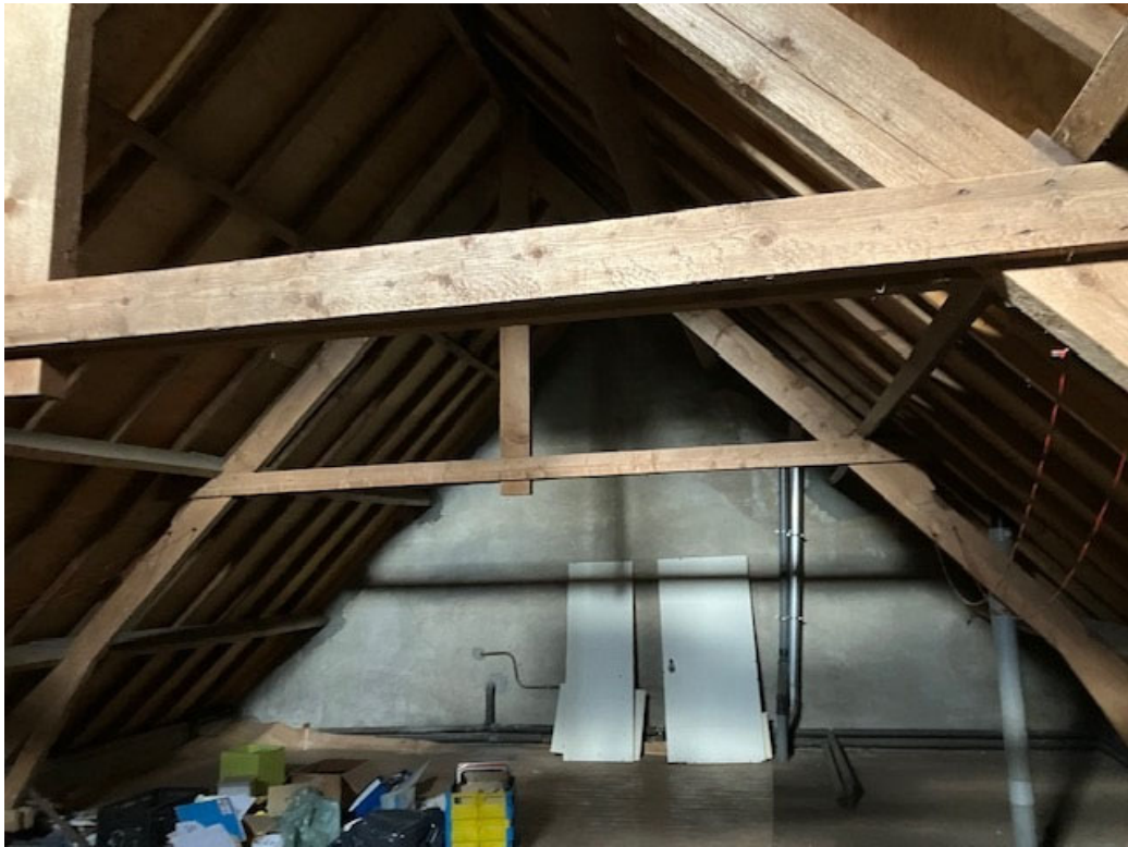
• Afbeelding 8: Zolder stalgedeelte, andere zijde is een brandmuur
