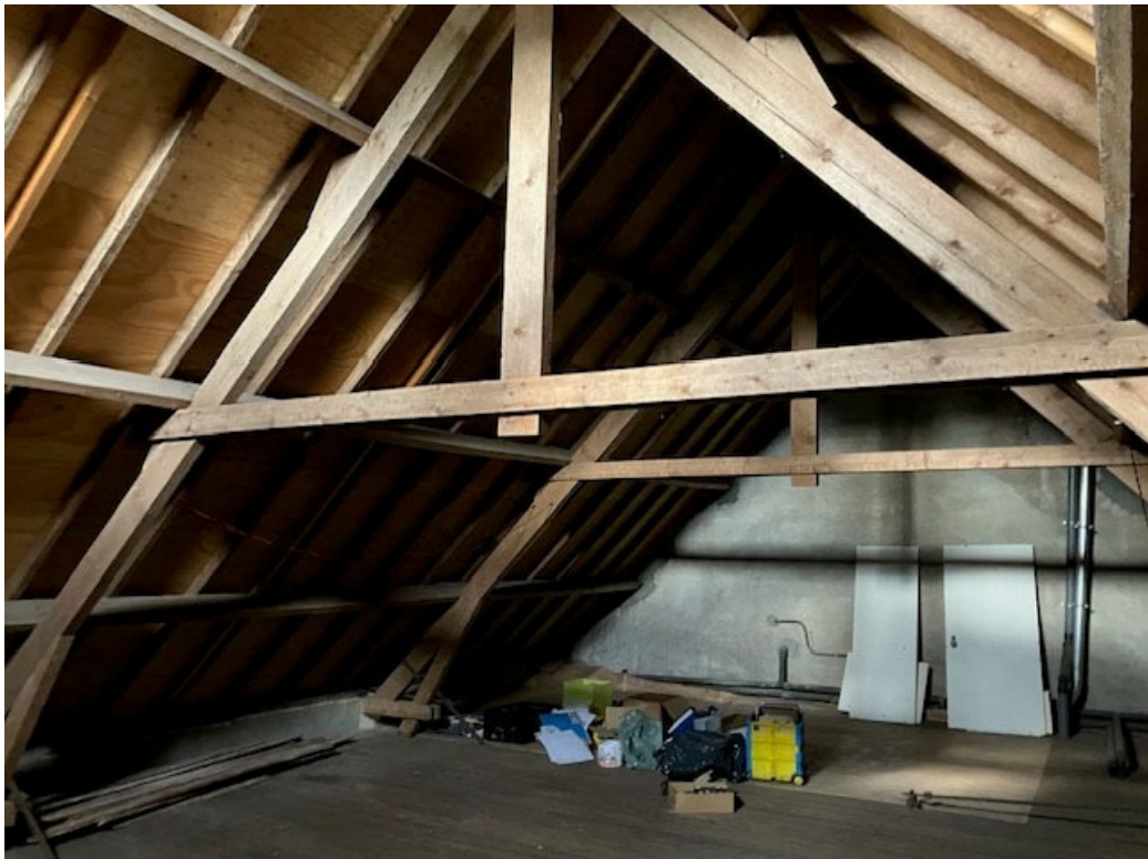
• Afbeelding 9: Zolder stalgedeelte, andere zijde is een brandmuur
