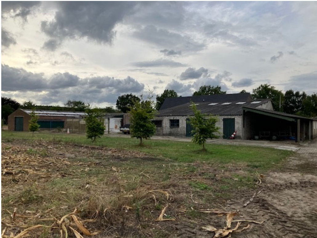
• Afbeelding 25: Achterzijde te slopen gebouwen
