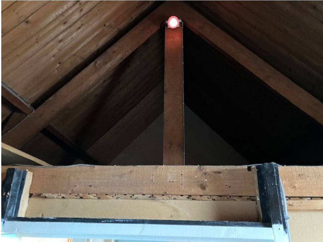
• Afbeelding 6: Zolder woonhuis
