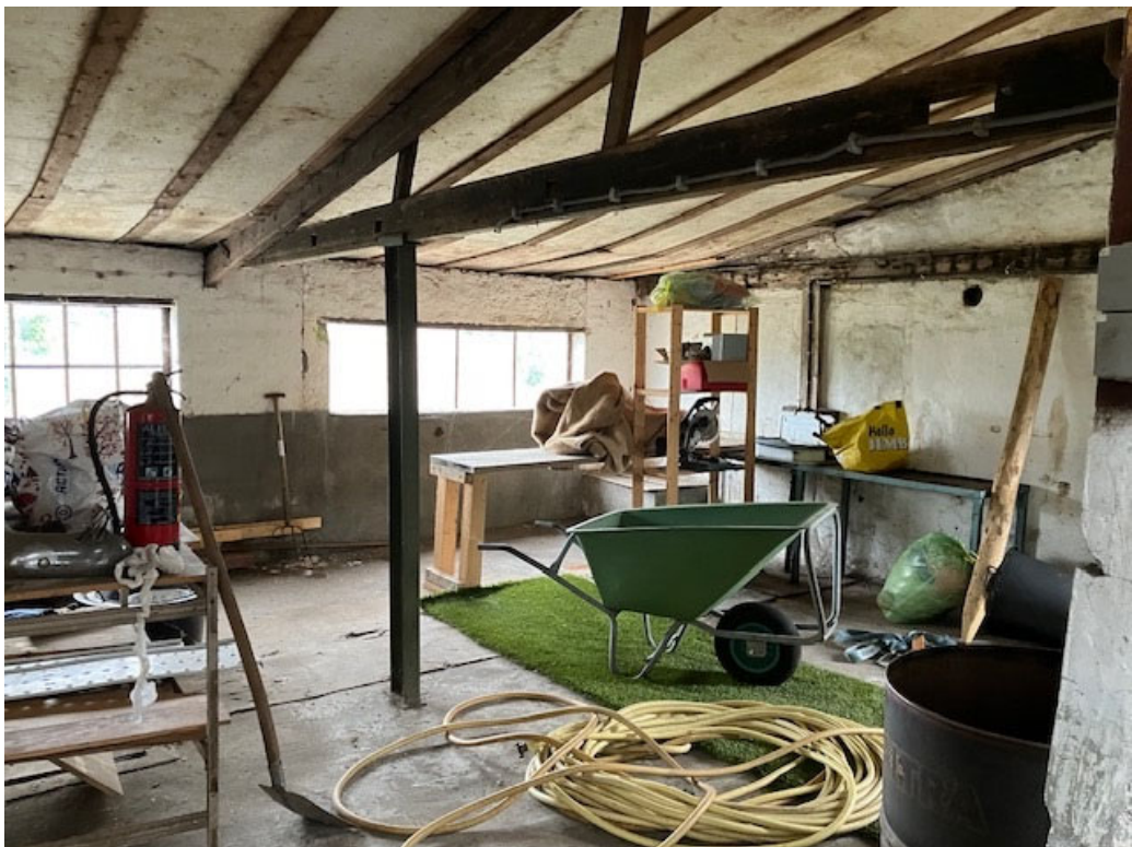
• Afbeelding 16: Binnenzijde te slopen bijgebouw
