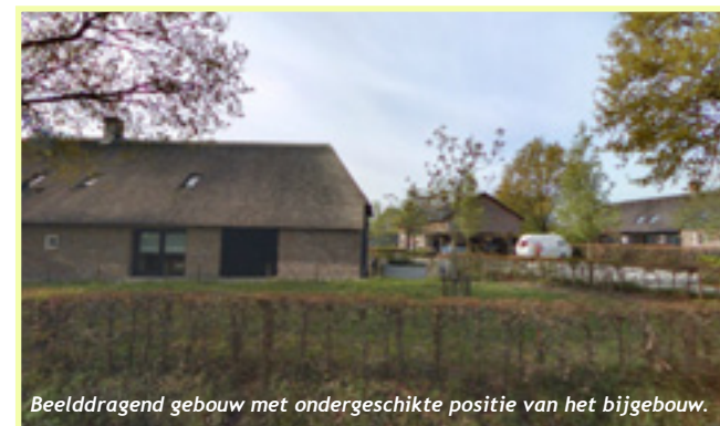
Bedrijfsbebouwing: sobere en doelmatige vormgeving en uitstraling.
