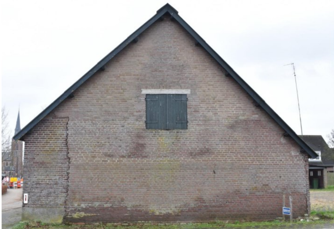
Figuur 10. Noordgevel van het bedrijfsgedeelte.
