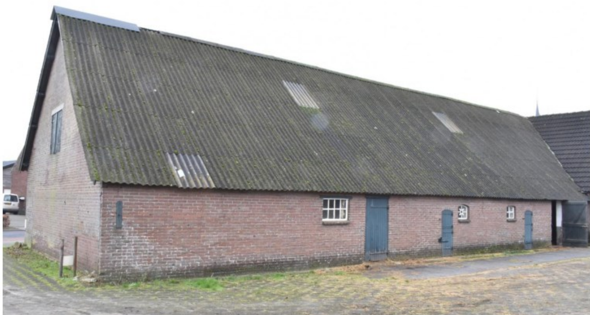
Figuur 9. Overzicht van de westgevel van het bedrijfsgedeelte.
