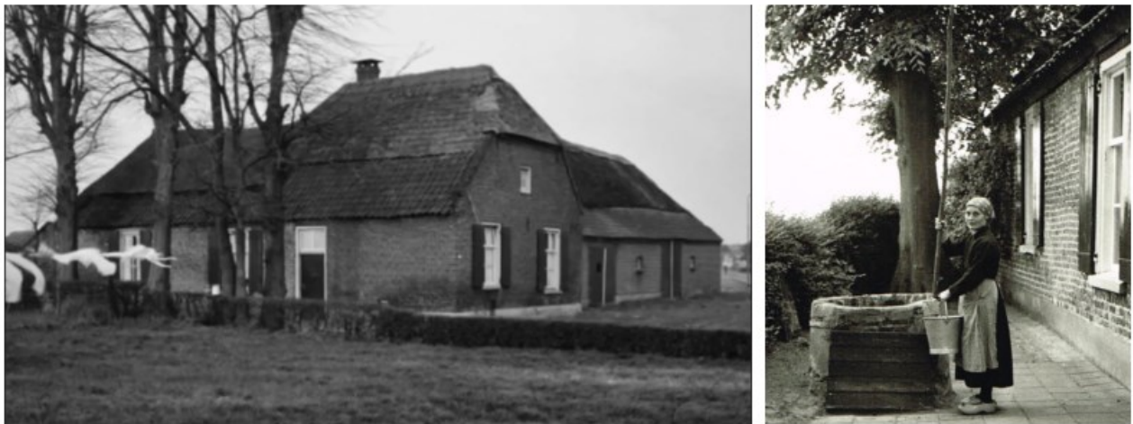
Afbeelding 18. Foto uit 1964 (bron: RCE) en een foto van de toenmalige bewoonster bij de put
