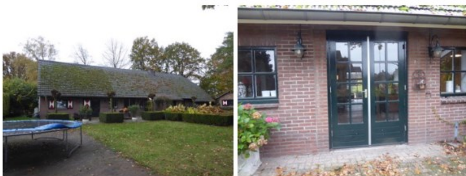
14. Achtergevel (links) en aanpassing metselwerk voor recente vensterinvulling (rechts)
