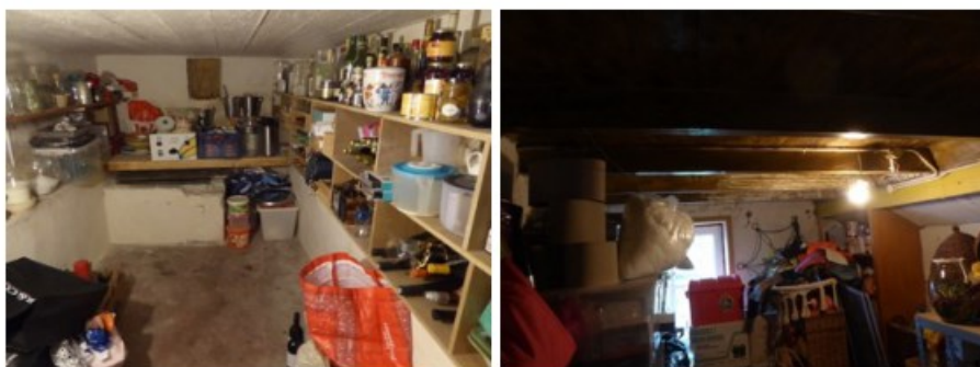
18. Kelder onder betonvloer (links) en opkamer gedeeltelijk onder schuin dak (rechts)
