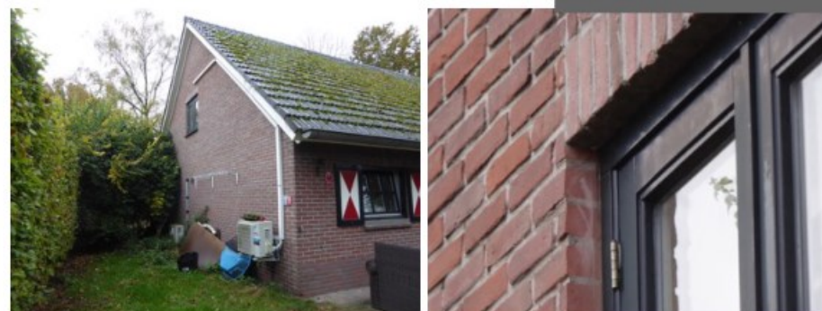
16. Achtergevel (links) en aanpassing metselwerk voor recente vensterinvulling (rechts)
