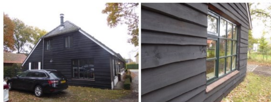
13. Linker zijgevel (links) en in 1997 vernieuwd venster waar voorheen de voordeur zat (rechts)
