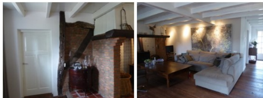
19. Ankerbalkgebint tegen brandmuur (links) en stalen onderslagbalk en balklaag (rechts)
