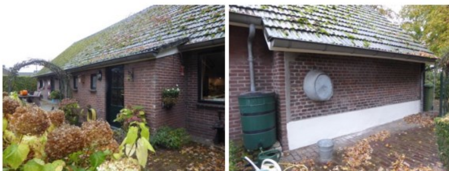
15. Vensters toilet en ingang in aanbouw (links) en verbrede opkamer en kelder in aanbouw (rechts)
