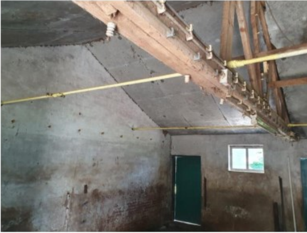
Indruk van de binnenzijde te slopen kalverstal.
