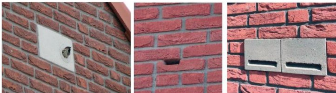
Foto's: Voorbeelden geïntegreerde nestruimtes in bebouwing voor huismus en vleermuizen.
