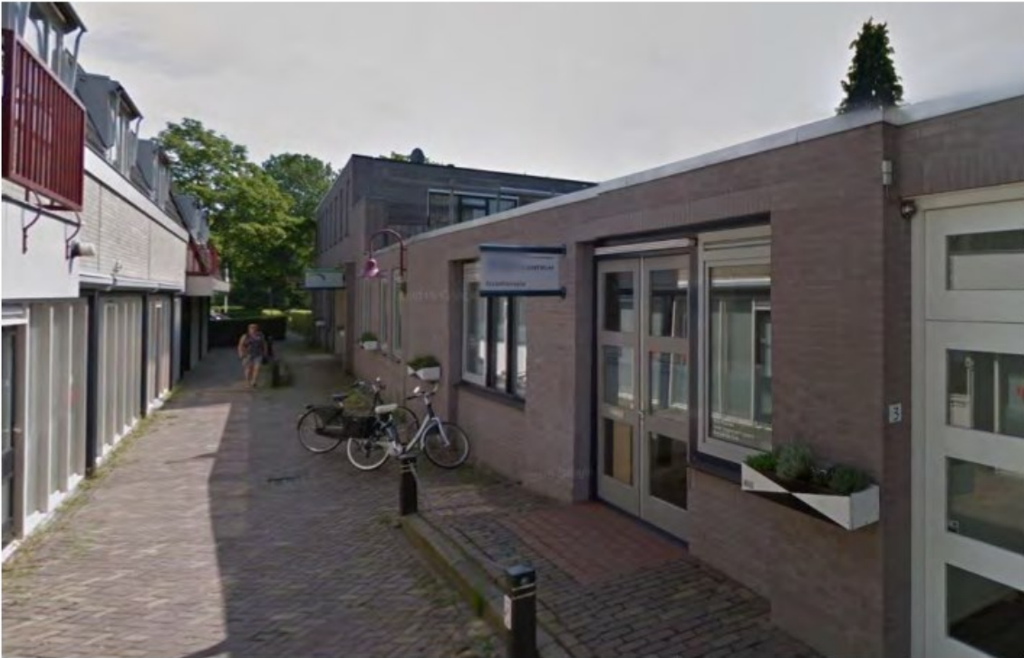
Voormalige situatie plangebied, steeg Karbeel (Bron: Google Maps)
