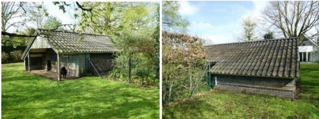
Afbeelding 3 en 4: Te slopen schuurtje ten zuiden van de woning. Bron: BNL advies. Datum: 21-04-2023
