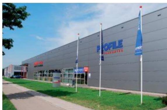
bedrijfsnaam op de gevel, bord en vlaggenmasten
