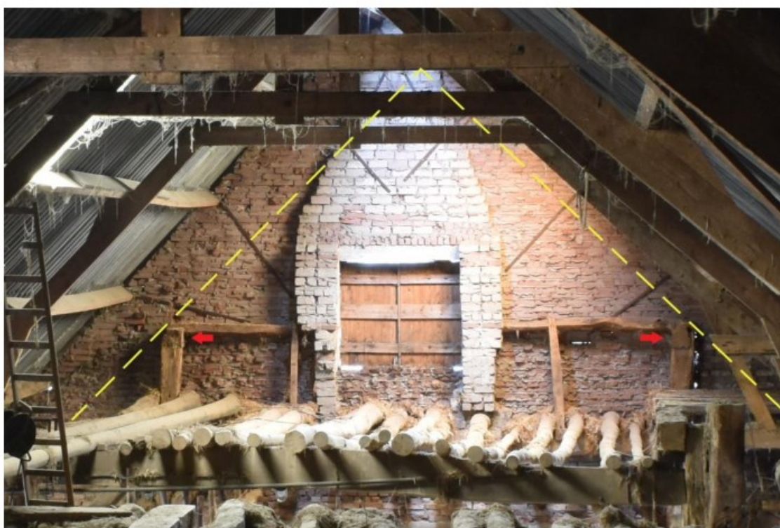
Figuur 22. Detail van het meest noordelijke gebint tegen de vernieuwde kopgevel. De afgezaagde gebintplaten op de gebintstijlen zijn hier nog goed zichtbaar (rode pijlen). In geel is het gereconstrueerde oude dakvlak aangegeven.
