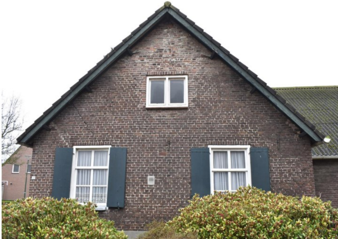
Figuur 13. De oostgevel van het woongedeelte waarbij bovenin de verlenging van de voorheen afgewolfde gevel van na 1964 zichtbaar is.
