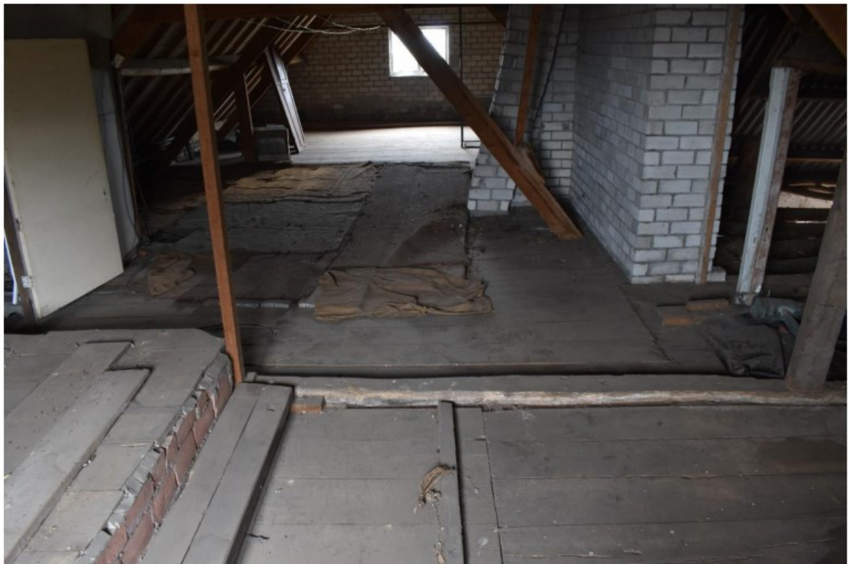
Figuur 18. Zolderverdieping verdeeld in drie traveeën. Aan de voorzijde het oostelijke travee met oude vloerdelen met luik. In het midden een travee met ook nog oude vloerdelen en achter in de west travee met smallere vloerdelen uit het einde van de 19de eeuw. Tussen de eerste en tweede travee is nog een balk aanwezig die mogelijk nog bij de oorspronkelijke van boerderij voor 1832 hoort. Aan de rechterzijde is de jonge brandmuur en schouw zichtbaar.
