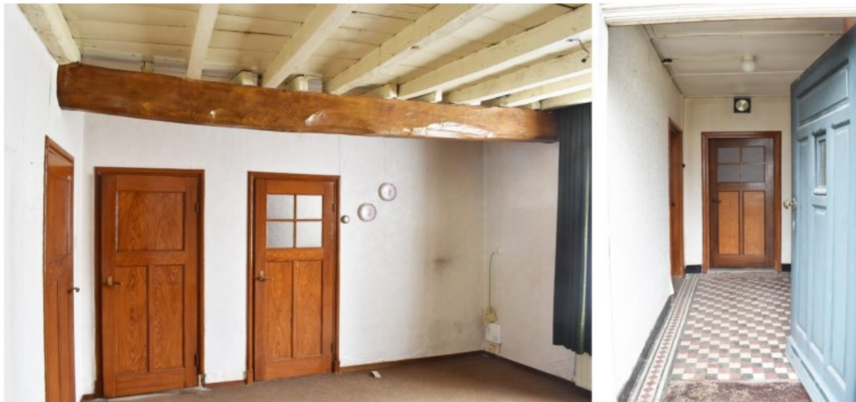
Figuur 16. Woongedeelte met links de woonkamer met Bruynzeel deuren met houtimitatie en de meest oostelijke moerbalk. Rechts is de gang zichtbaar met cementtegels uit het einde van de 19 de eeuw. Alle deuren die in verbinding staan met de gang hebben een bovenlicht met kruislings geplaatste houten roeden.
