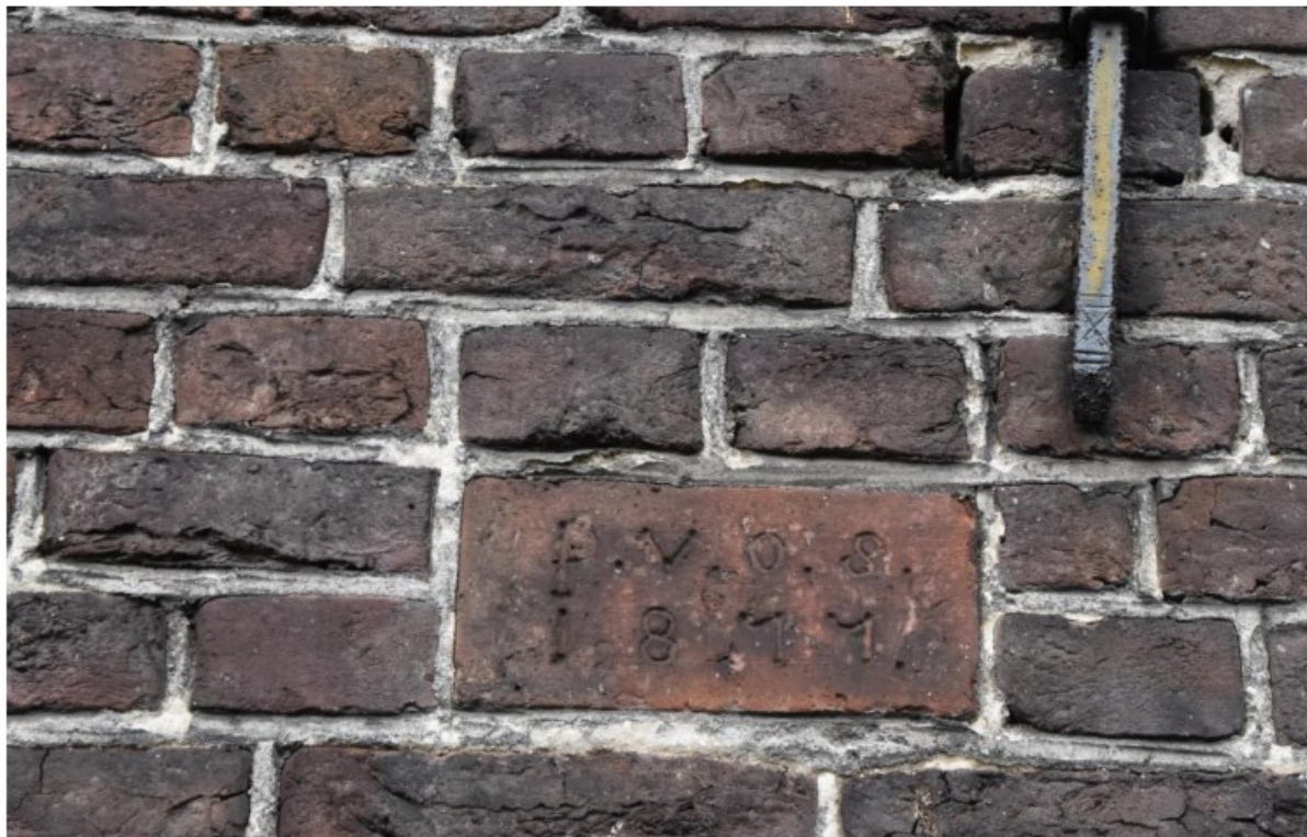
Figuur 6. Gevelsteen aan de oostzijde van het woongedeelte met daarop de tekst P.V.O.8, 1877
