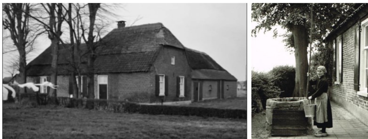
Afbeelding 18. Foto uit 1964 (bron: RCE) en een foto van de toenmalige bewoonster bij de put
