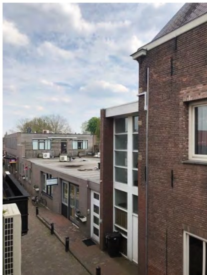
De bestaande verharde platte daken tussen pand Gelind en Prinzenhuis.
