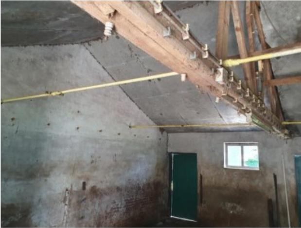
Indruk van de binnenzijde te slopen kalverstal.
