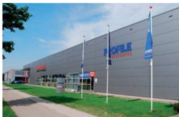
bedrijfsnaam op de gevel, bord en vlaggenmasten
