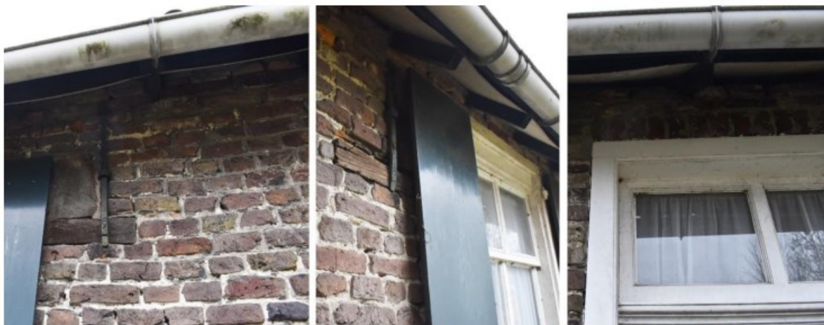
Figuur 15. Details in de zuidgevel. Links en in het midden de twee in de buitenmuur opgelegde balken van oost naar west. Rechts de profilering van deurportaal en bovenlicht.
