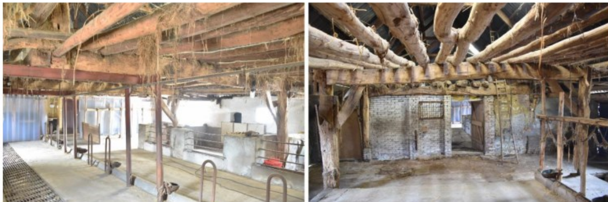
Figuur 19. Overzicht stal. Links het zuidelijke stalgedeelte waar drie gebintstijlen zijn afgezaagd en vervangen door ijzeren stijlen. Rechts het noordelijke deel van het bedrijfsgedeelte dat mogelijk het schuurgedeelte was.
