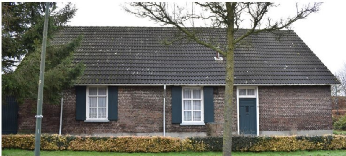
Figuur 14. De zuidgevel van het woongedeelte.
