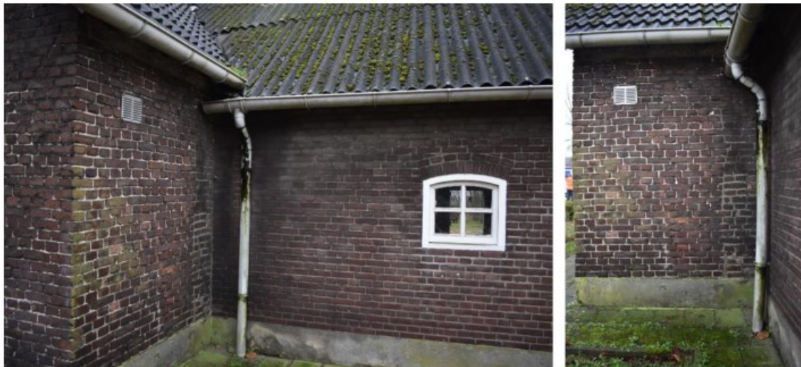
Figuur 12. De aansluiting van de het bedrijfsgedeelte op het woongedeelte. Rechts, in de noordgevel van het woongedeelte, een detail van de bouwsporen in de vorm van een bloktand, die samenhangen met de wijzigingen in 1941.
