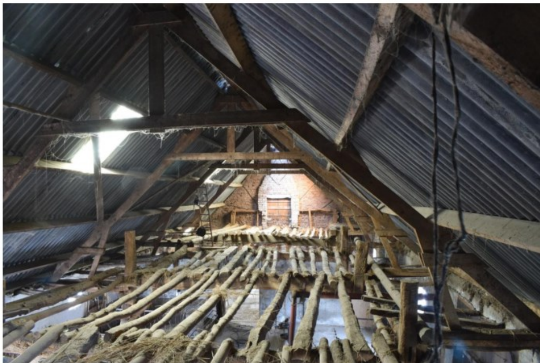
Figuur 21. Overzicht van de vliering van de stal vanuit het zuiden met zicht op de slieten voor het hooi en de jongere gordingenkap die na 1941 is aangebracht. De gebintstijlen steken boven de slieten uit. Alleen in de meest noordelijke travée is aan de oostzijde nog een gebintplaat aanwezig
