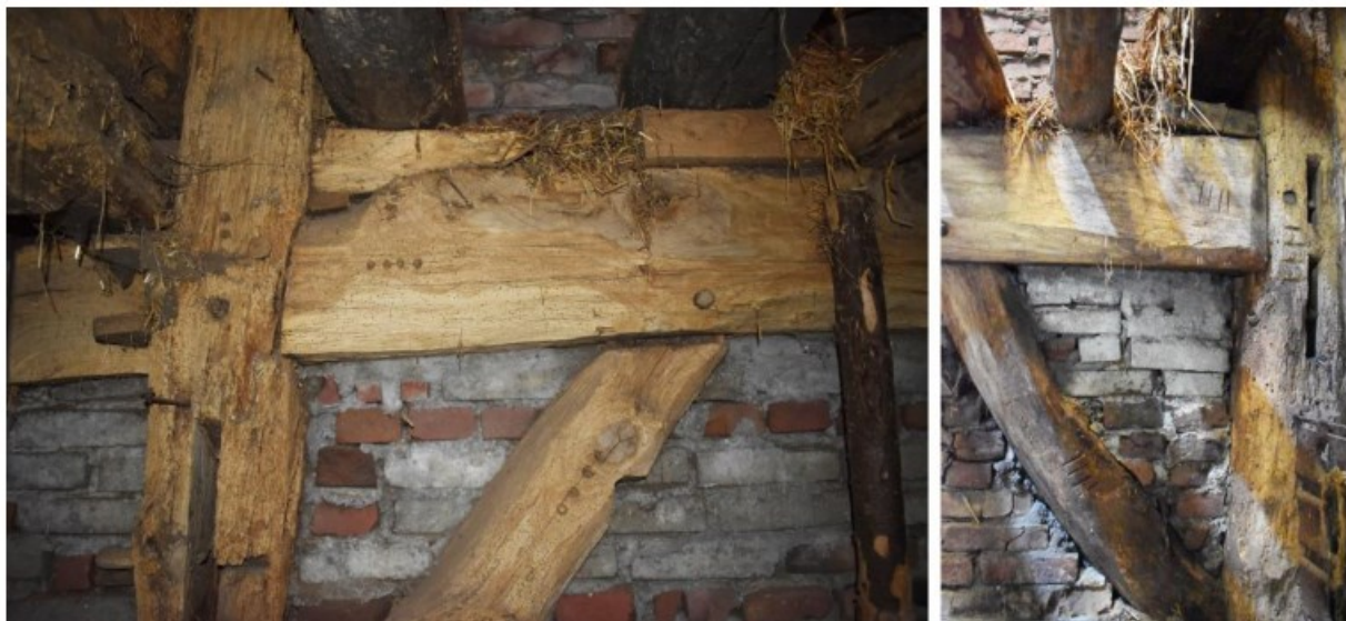
Figuur 20. Details van het strijkgebint met het telmerk vier. Het onderscheid tussen links en rechts wordt aangegeven met gehakte telmerken aan de rechterzijde en gaatjes aan de linkerzijde.
