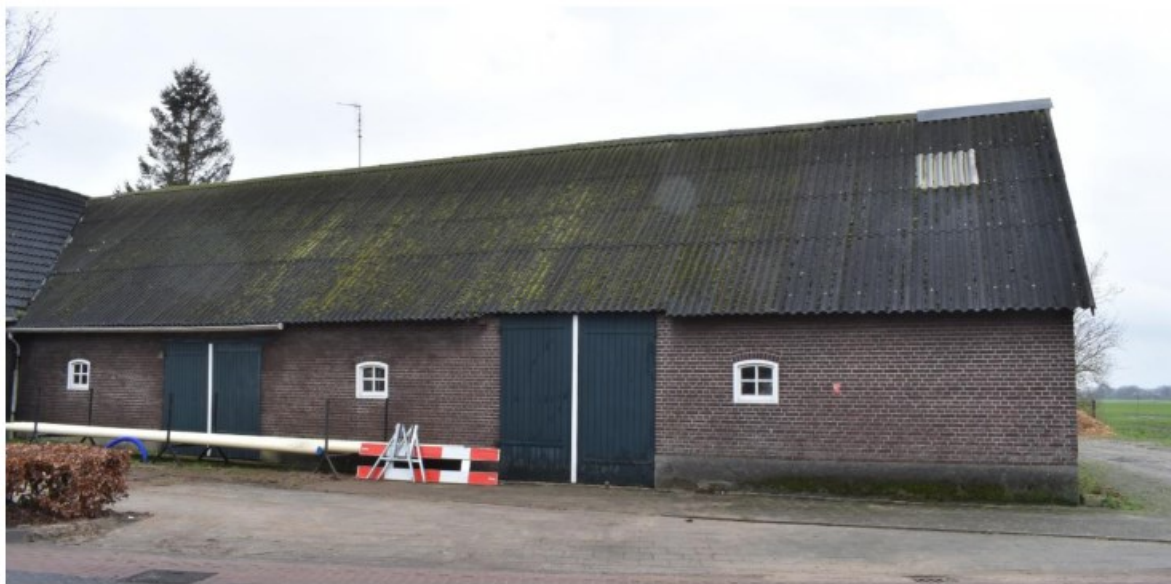
Figuur 11. De oostgevel van het bedrijfsgedeelte gezien vanaf het oosten.
