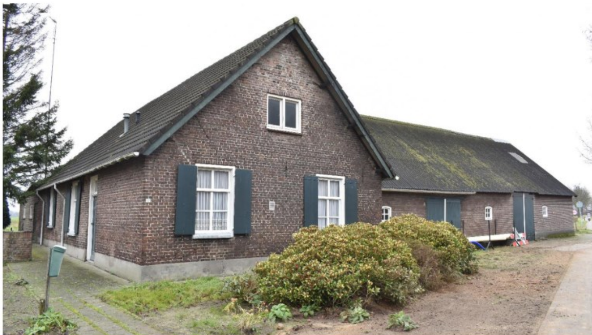
Figuur 1. Onderzoekspand Sint Antoniusstraat 17 in De Mortel, gezien vanuit het zuidoosten.
