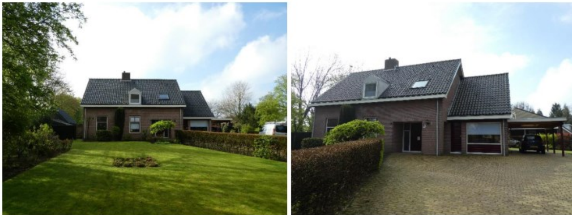
Afbeelding 3 en 4: Bestaande te behouden bebouwing ten zuiden van de nieuw te bouwen woning. Bron: BNL advies.
