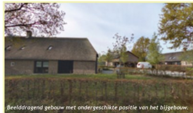
Bedrijfsbebouwing: sobere en doelmatige vormgeving en uitstraling.
