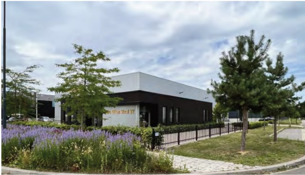
(afb. 93) Kruising Recheloop en IJzerzijk, Gemert / bron: gemeente Gemert-Bakel
