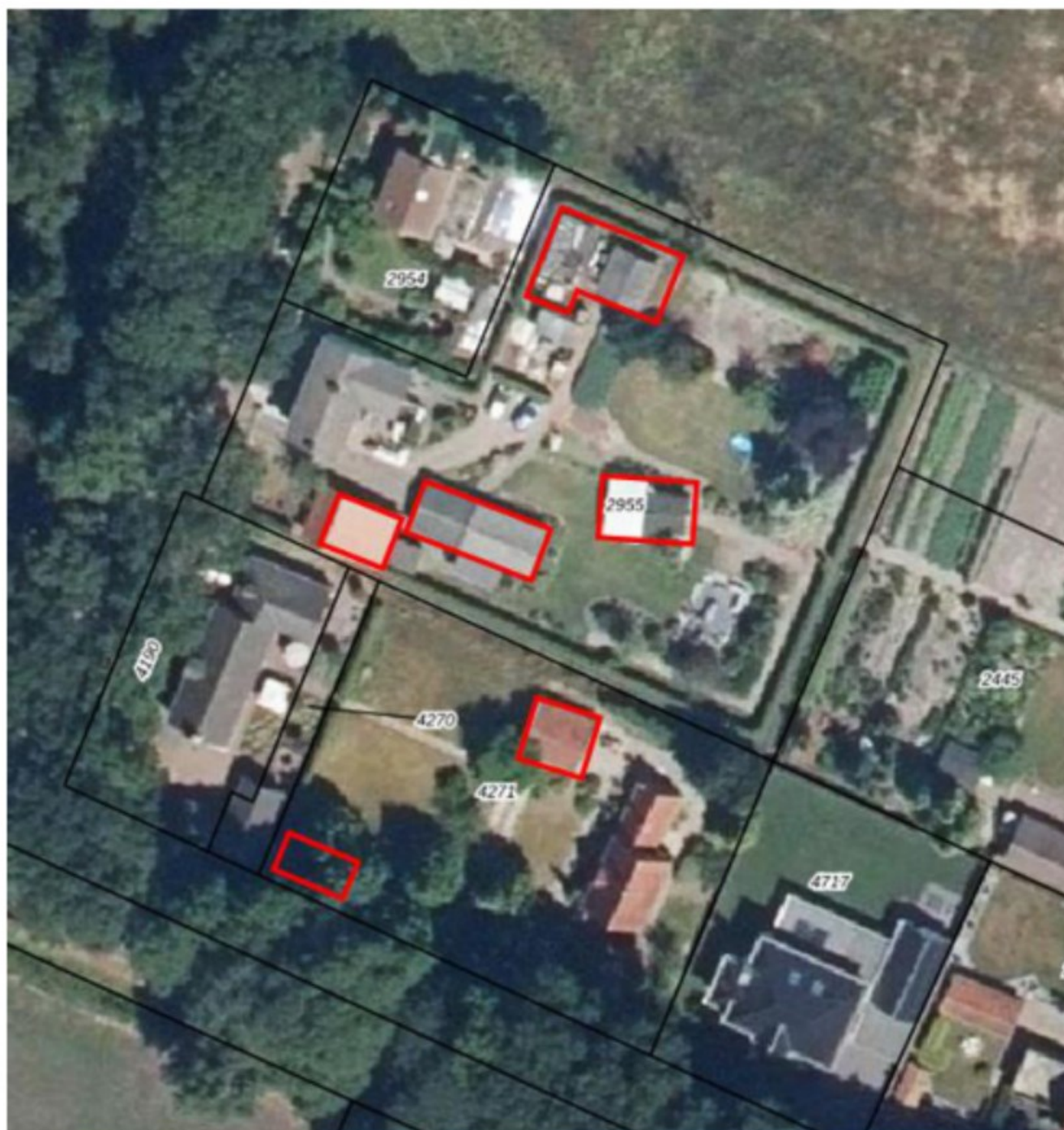
Figuur 3 Luchtfoto met te slopen bijgebouwen rood omkaderd
