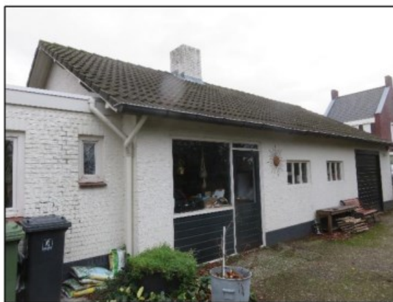
Foto 2. Westzijde van de schuur
