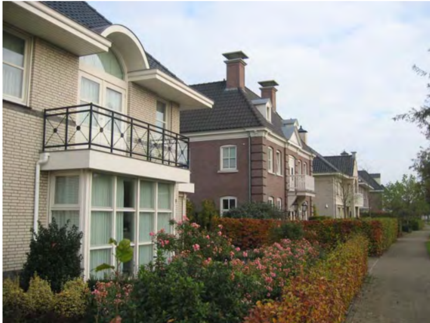
^ recente nieuwbouw Gemeente Gemert-Bakel
