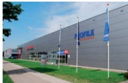
bedrijfsnaam op de gevel, bord en vlaggenmasten
