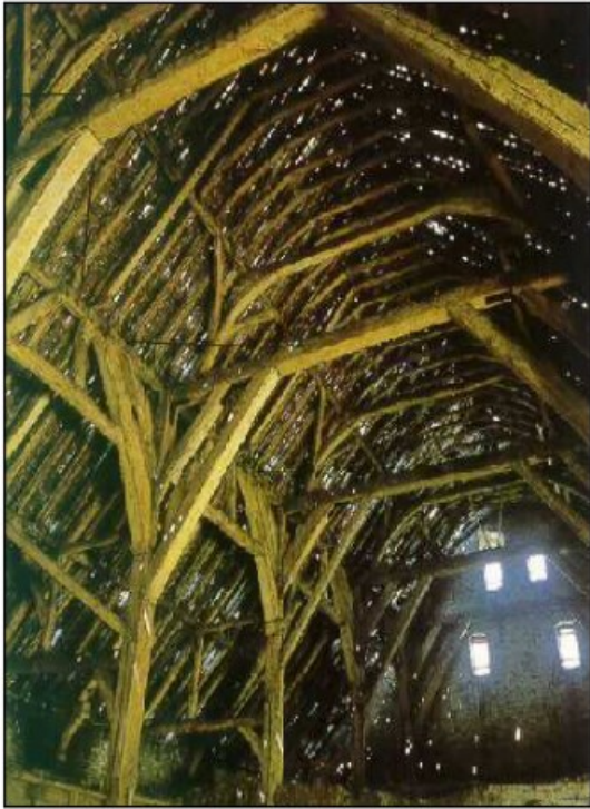
Het principe van de agrarische hut. Het houten gebint schraagt het dak.
