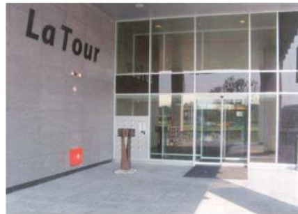
duidelijk herkenbare entree
