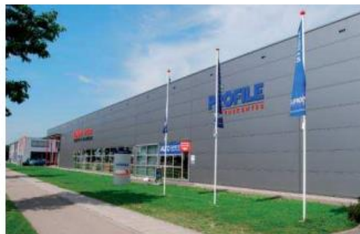
bedrijfsnaam op de gevel, bord en vlaggenmasten
